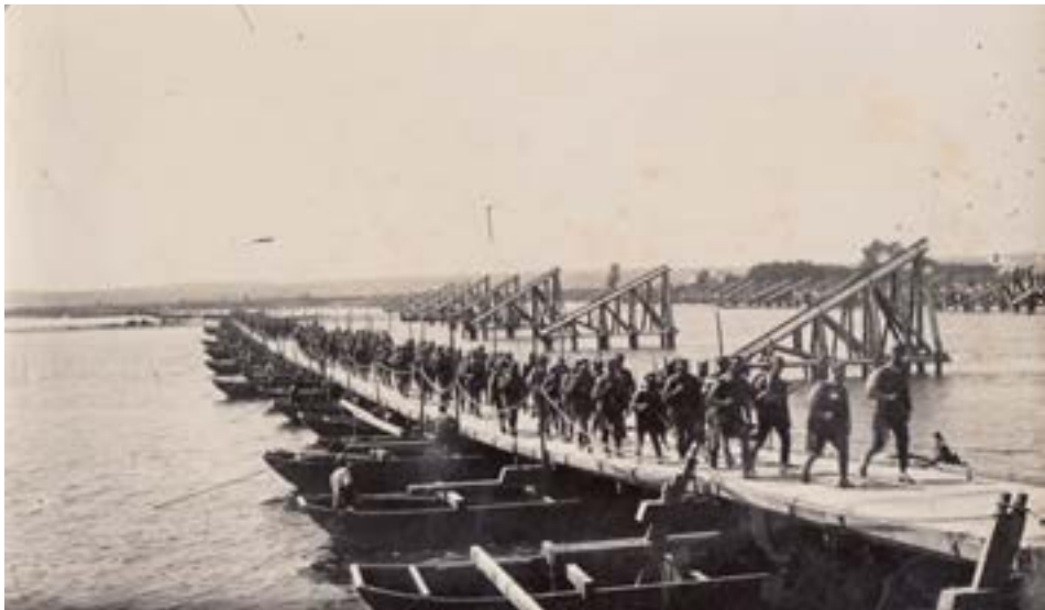
Przeprawa po moście pontonowym
